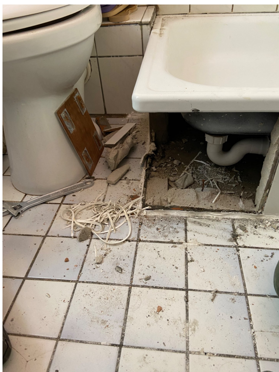
2024-05-02 14:47:02 Rob Boessen Douchebak verwijderen was niet mogelijk. Zijkant tegelwerk weggehaald.
